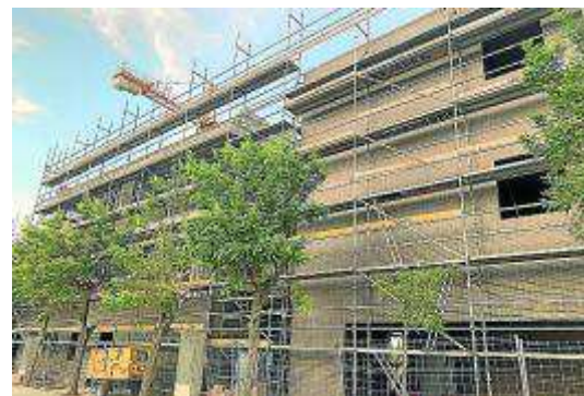
Obras del nuevo colegio Odón de Buen.
